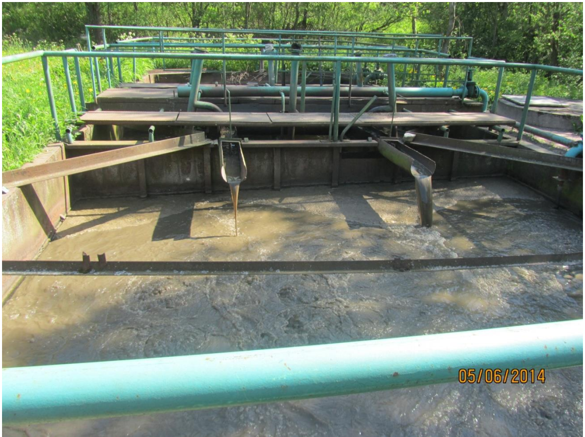
Рис. 7. Аэротенк
