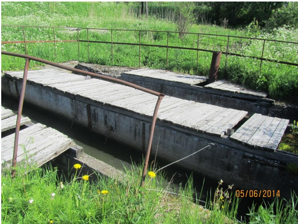
Рис. 6. Первичный отстойник.
